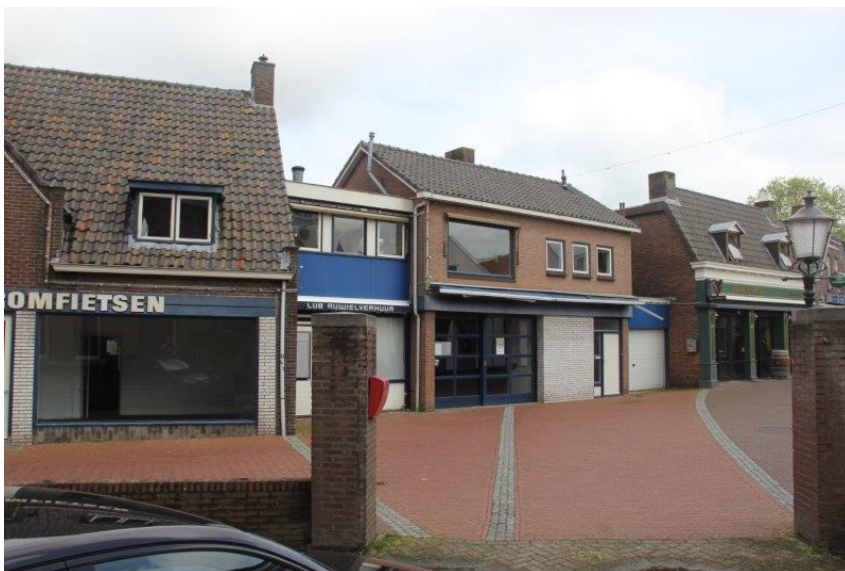
Deel van het zuidelijke en het gehele noordelijke pand.
