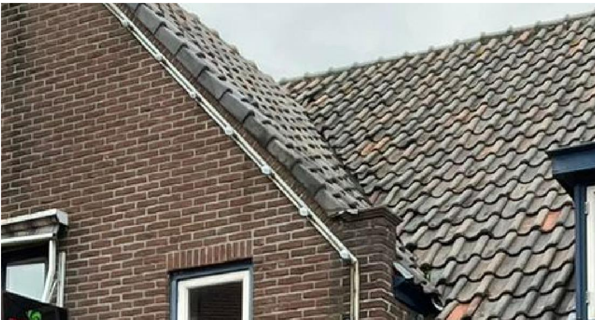
Figuur 6- Pannendak op de planlocatie met potentiële verblijfplaatsen.
