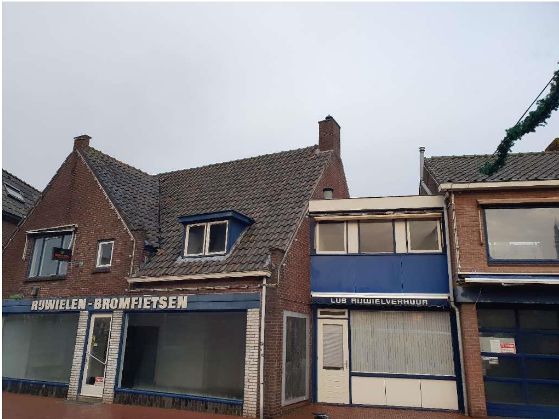
Deel bedrijfspand + schuren aan de Bermerstraat 1 te Ommen
