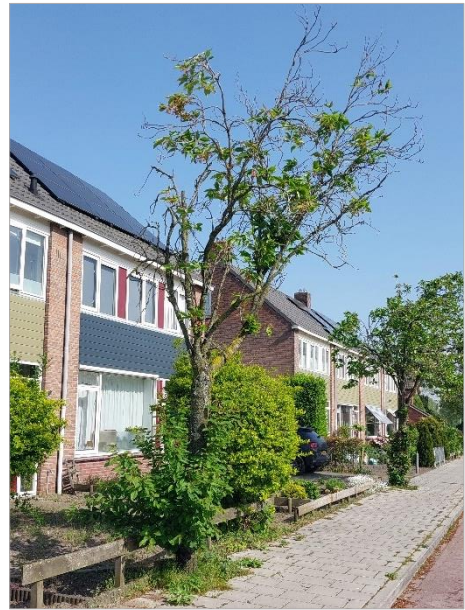
afb. 28: In woonwijken staan soms structuren van slechte kwaliteit, zoals hier aan de Jonkheer van Nahuysstraat in Ommen
